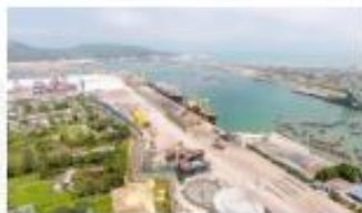
Thanh Hóa: khởi công đường nối QL.1A vào khu kinh tế Nghi Sơn (19/02/2024)
